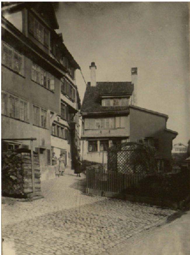
Häuserzeile links Lämmli brunnenstr. 27, 29 (, 35), 9000 St. Gallen. Davor das Doppelhaus (v.l.n.r.) Nr. 31 u. 33 (1890).
